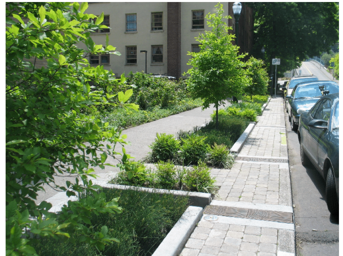
Abb. 19 hydrologisch optimierter Baumstandort
