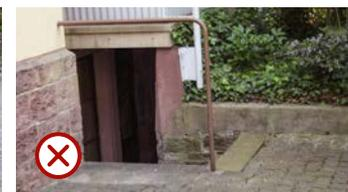
**Bei außenliegenden Kellertreppen** kann durch eine Schwelle und/oder eine Überdachung verhindert werden, dass Oberflächenwasser in die Kellerräume läuft.
