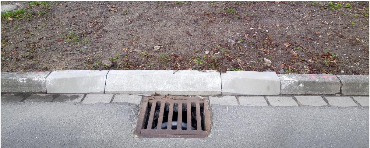
Flachbordstein F10 an der Brinkstraße
