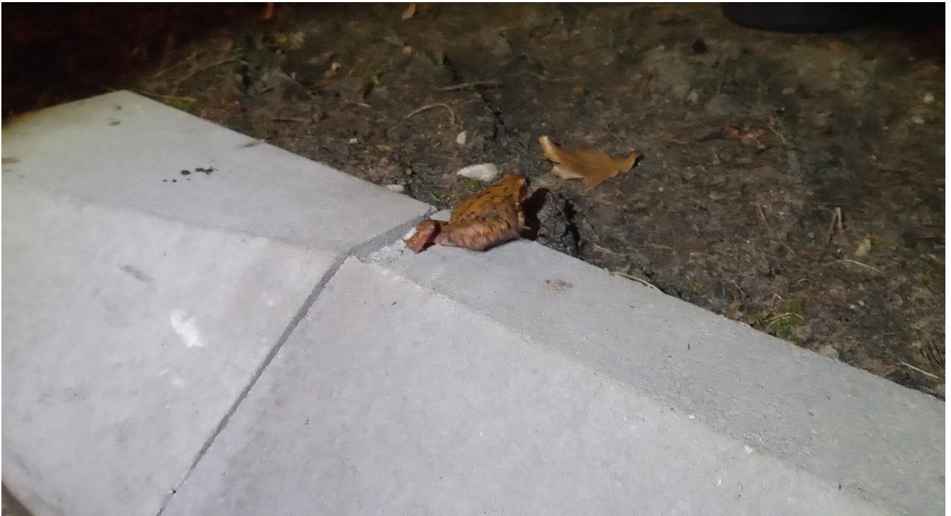
Auch für einen Single Grasfrosch stellt der Bordstein als Flachbord vom Typ F15 kein Problem mehr dar.
