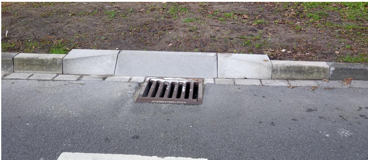
Flachbordstein F15 an der Brinkstraße
