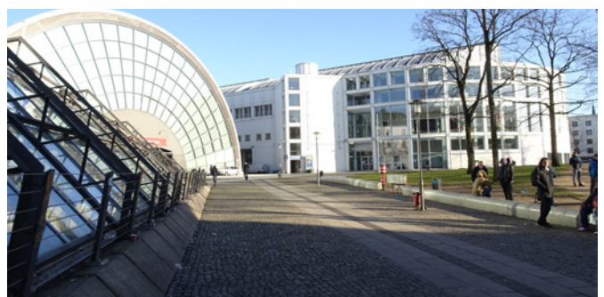
Umfeld des Stadtbahnabgangs
