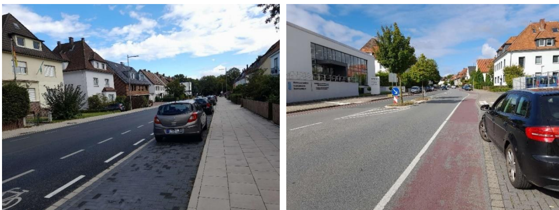
Abbildung 14 Eindrücke der Netzbefahrung (Radverkehrsführung mit und ohne Sicherheitstrennstreifen) (Quelle: INOVAPLAN GmbH)
