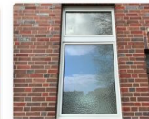
Fenster - außen, Strukturl...
