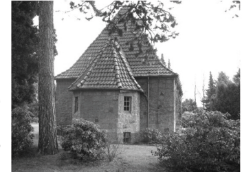
Blick auf die Rückseite der Kapelle
